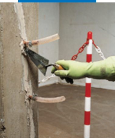
Фиксация инъекторных трубок с помощью Adesilex PG1
