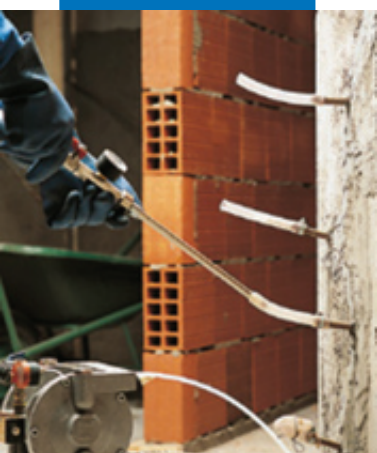
Инъекция Epojet в колонну с трещинами
