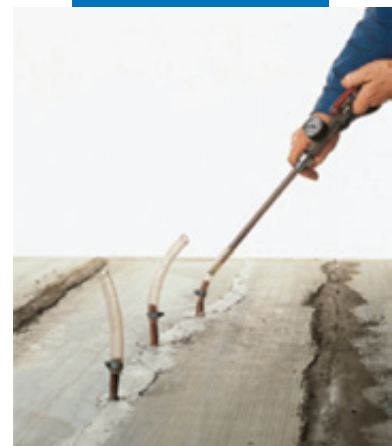
Восстановление горизонтальной конструкции инъекцией E-rojet
