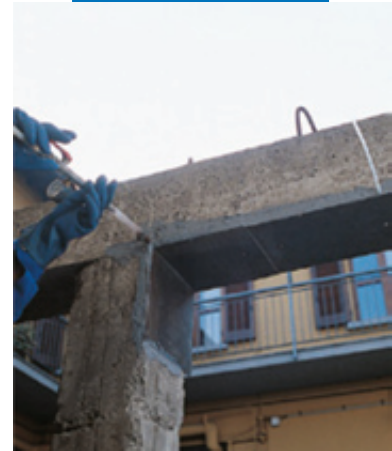
Ремонт балки инъекцией E-rojet
